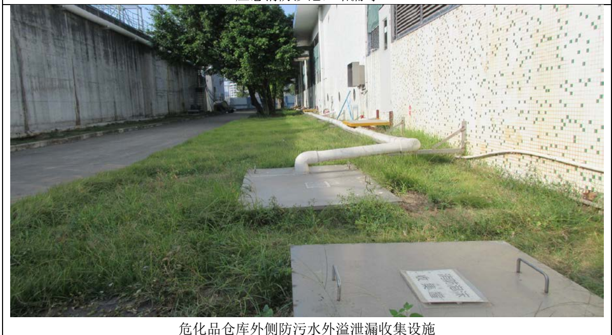
图 4.1-4 危化品堆场、危废暂存间土壤污染防治情况现场图
