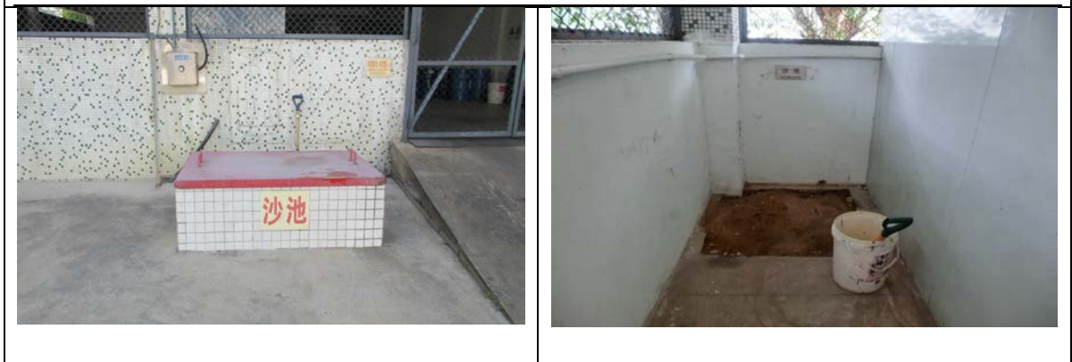
应急消防沙池：堵漏等
