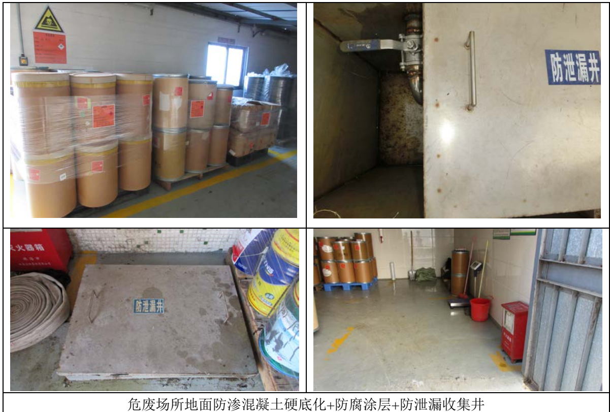
图 4.1-3 危废暂存间土壤污染防治情况现场图
